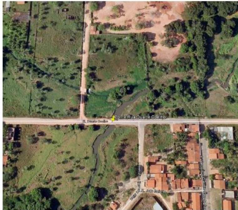
Figura 2 – Localização da Ponte Rua Duarte Coelho
