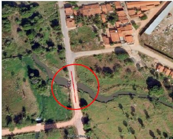
Figura 1 – Vista da travessia da Rua Duarte Coelho sobre curso d'água.
